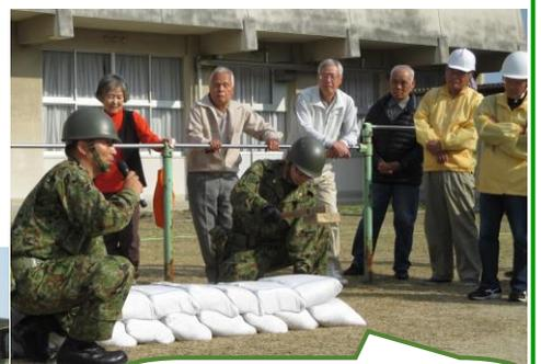
土のうはひし形に積み、たたいて固めます。
