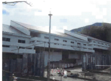
改修工事を終えた屋根
