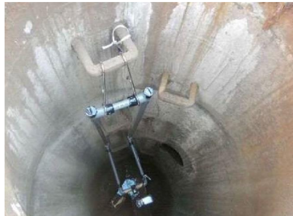
図 2.15 デジタルカメラ設置状況
