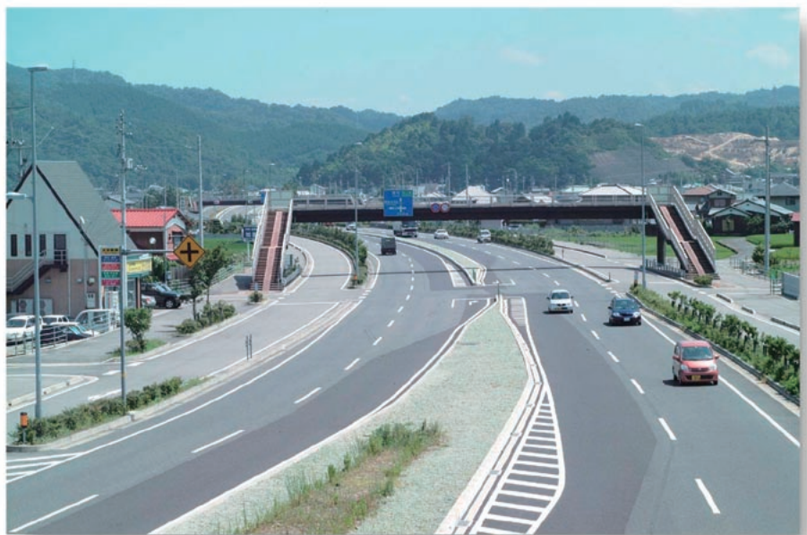
▲整備が進む国道11号新居浜バイパス
