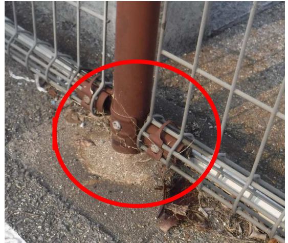
フェンス基礎部分
