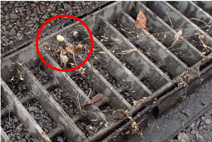
グレーチング内部
