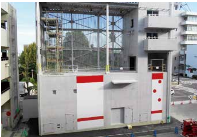
消防職員が訓練する施設（完成している訓練棟）
