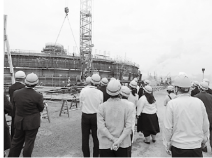
新居浜LNG基地建設現場現地調査
