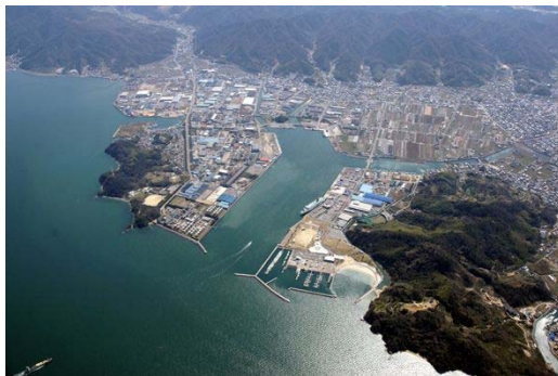
▲新居浜港東港地区
