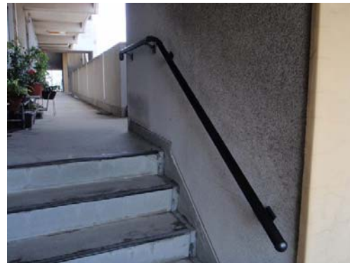
▲共用階段に整備された手摺（バリアフリー）
