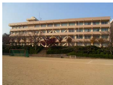
▲学校校舎耐震化工事
