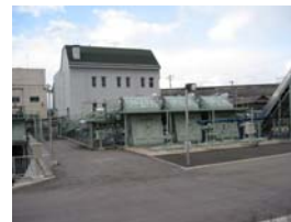
▲ 土場ポンプ場
