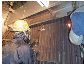
ガス切断機を使ってボイラーチューブ交換部分を切り取ります
