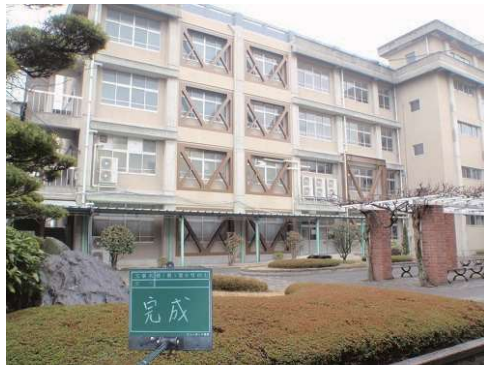
仕事現場：完成（東高）
