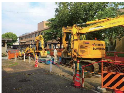
仕事現場：施工中（高専）
