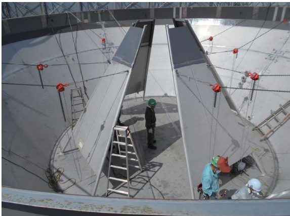
県外浄水場での現地工事
