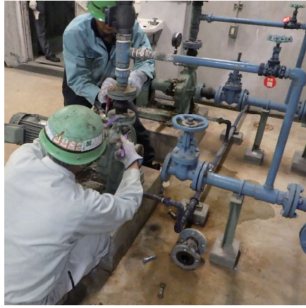
市内ポンプ設備現地工事
