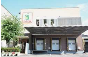
新居浜市の本社工場外観です。
