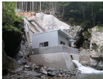
火力発電所外観・水力発電所外観
