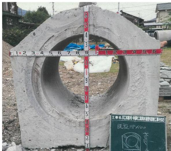
図 2.7 ヒューム管（導水管）の状態
