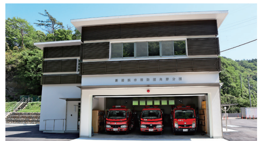
統合移転した角野分団詰所
