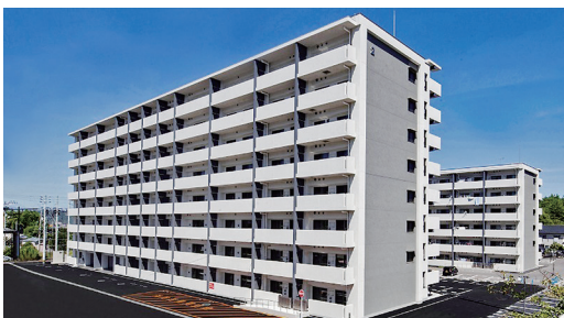
市営住宅東田団地（2号棟）の建築完了
