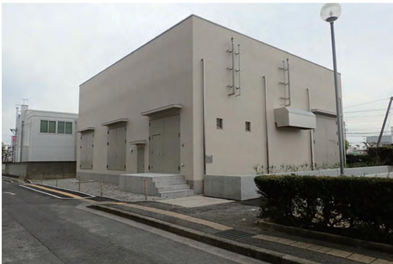
市庁舎受変電設備管理棟
