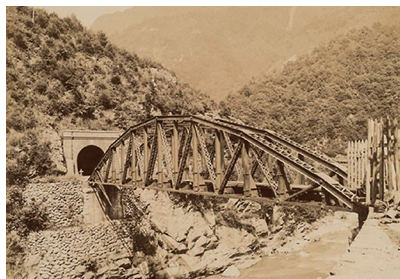
「端出場鉄橋及び隧道」(明治31年別子鉱山写真帳) 別子銅山記念館所蔵
