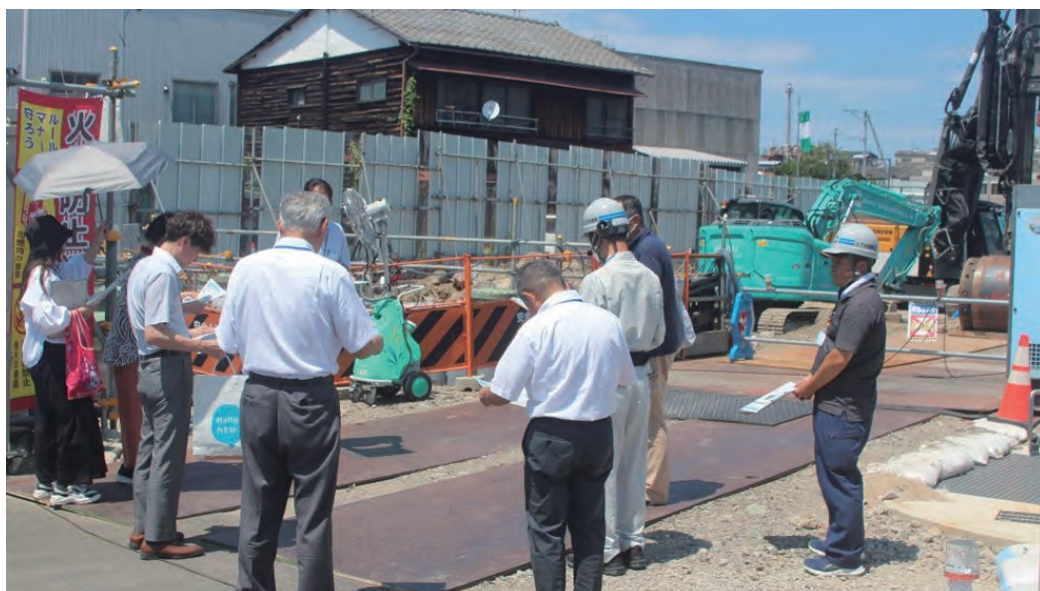
監査現地視察の様子：港町雨水ポンプ場
