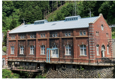
旧端出場水力発電所
