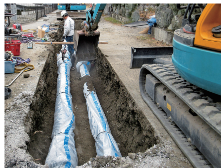
基幹管路の耐震対策の様子
