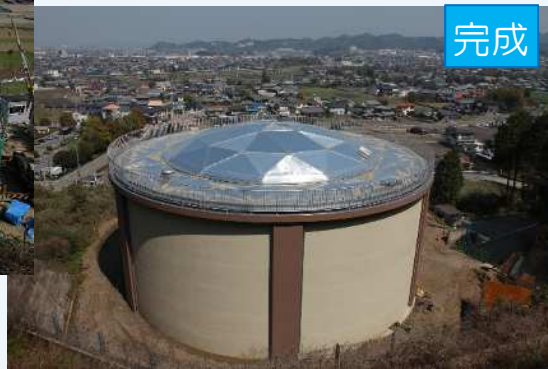
新山根配水池を築造しました。容量5,000m 3 の耐震型貯水タンクで、約2,000世帯へ水道水を供給します。
