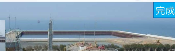
← ↑ 廃棄物埋立護岸 廃棄物を埋め立てるための護岸を作りました。みんなの生活などで出る廃棄物を処分します。
