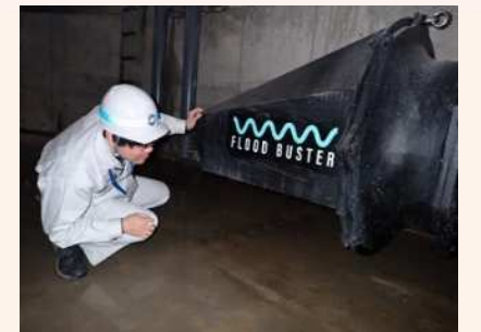
↑ 港町雨水ポンプ場（老朽化に伴う建替工事） 雨水をポンプで強制的に海に排水する施設です。建替中のポンプ据付状況を確認しています。
