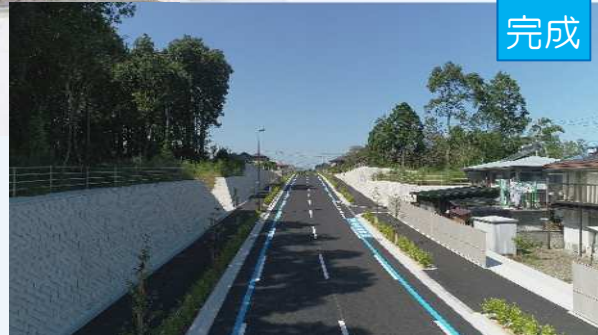
新しい道路を造ってます。道路の計画・設計・工事監督をします。
