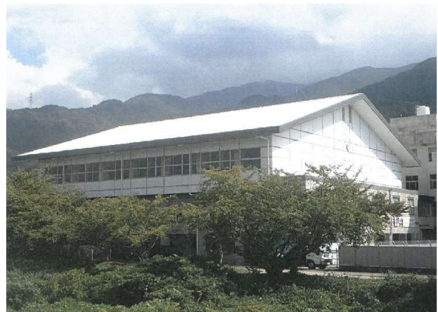
船木中学校体育館
