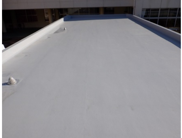
新居浜小学校プール付属室屋上
