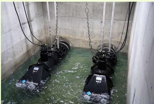
全速全水位全水位型横軸水中ポンプ
