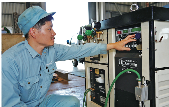
新工法に合わせて開発した制御装置
