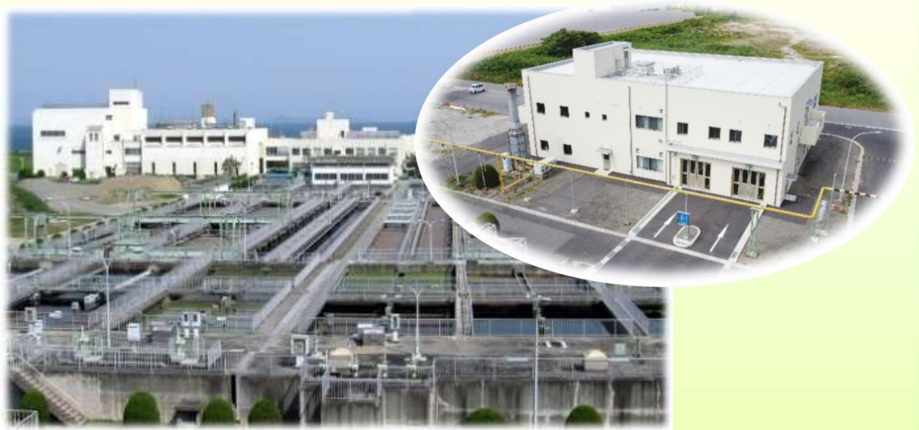
新居浜市下水処理場（全景）
