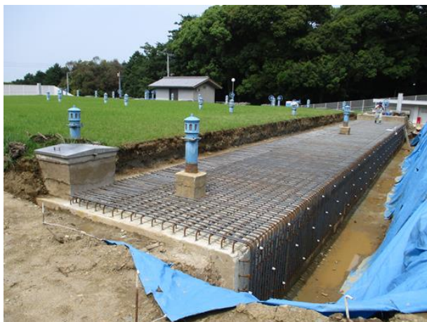
【配水池(写真左)と基幹管路(写真右)の耐震対策の様子】
