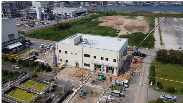
受入施設建設状況 R3. 6. 23 撮影
