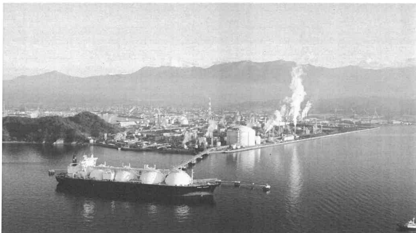
LNGタンカーと新居浜LNG基地
