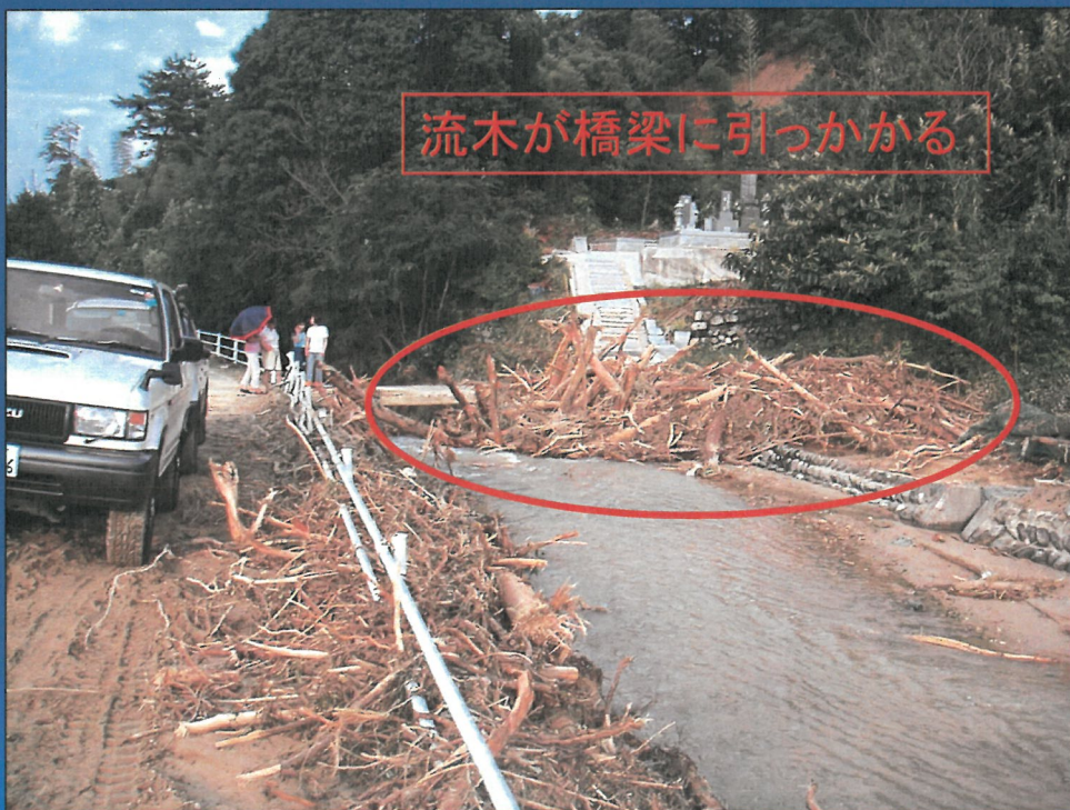
流木による河道閉塞状況
