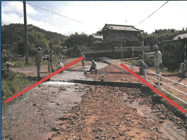
土砂による河道閉塞
