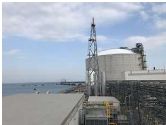
出典:住友共同電力株式会社 新居浜LNG基地
