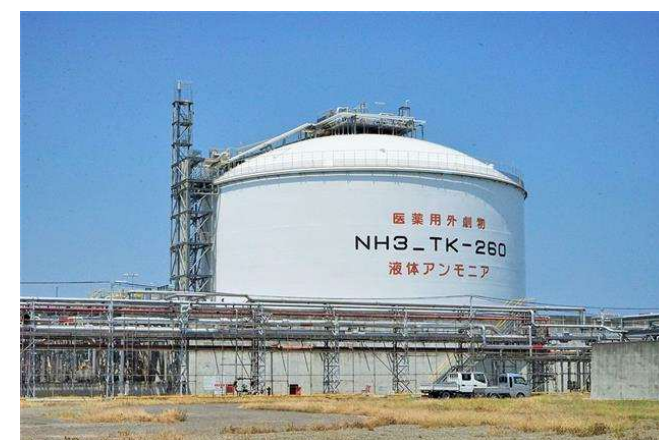
出典:化学工業日報 アンモニア貯蔵タンク
