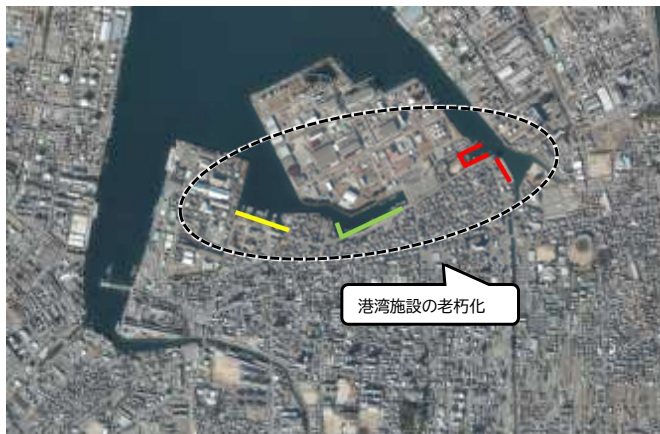
図 内港地区における港湾施設の老朽化
