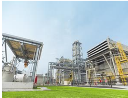
出典:住友共同電力株式会社 図 2.8 新居浜北火力発電所
