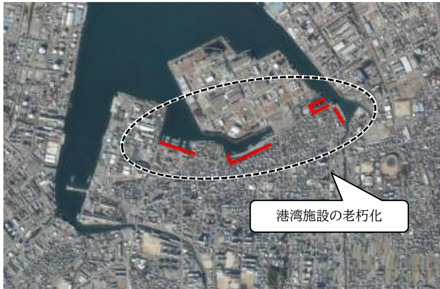
図 6.22 内港地区における港湾施設の老朽化
