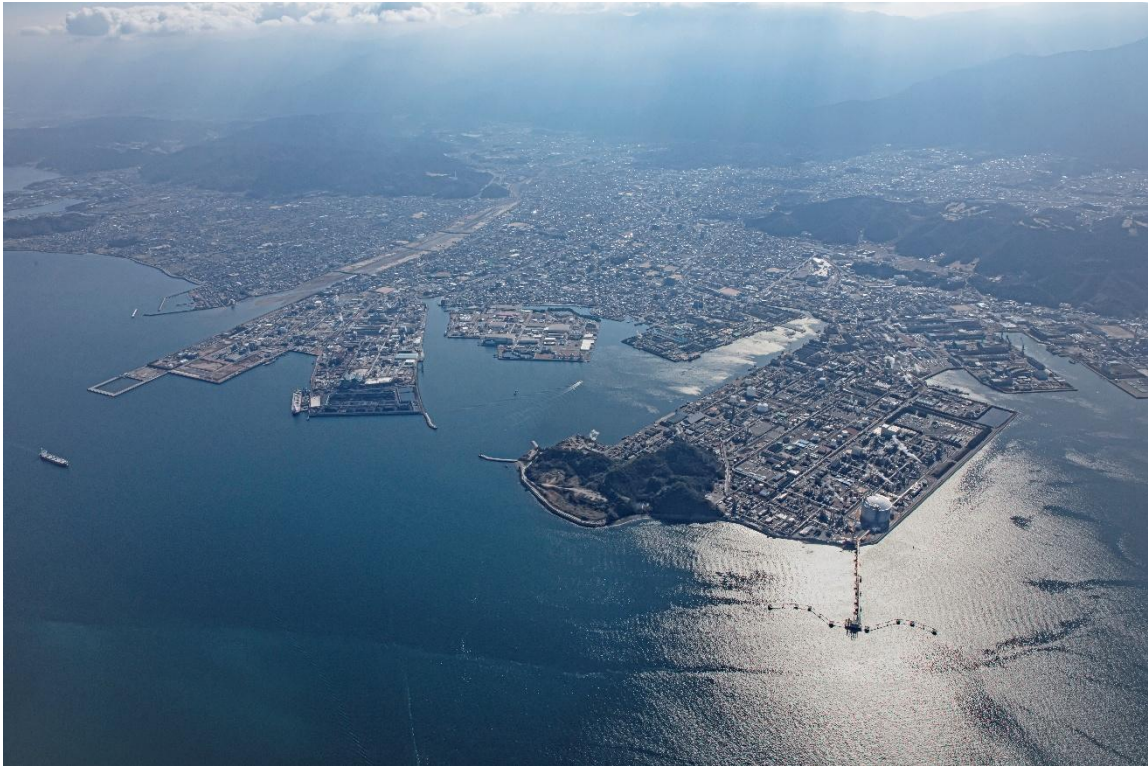
写真:四国地方整備局 松山港湾・空港整備事務所(令和4年2月撮影)
